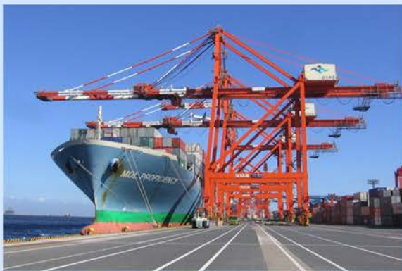
ガントリークレーン
