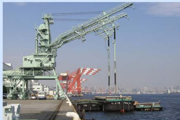
小麦の揚荷役作業
